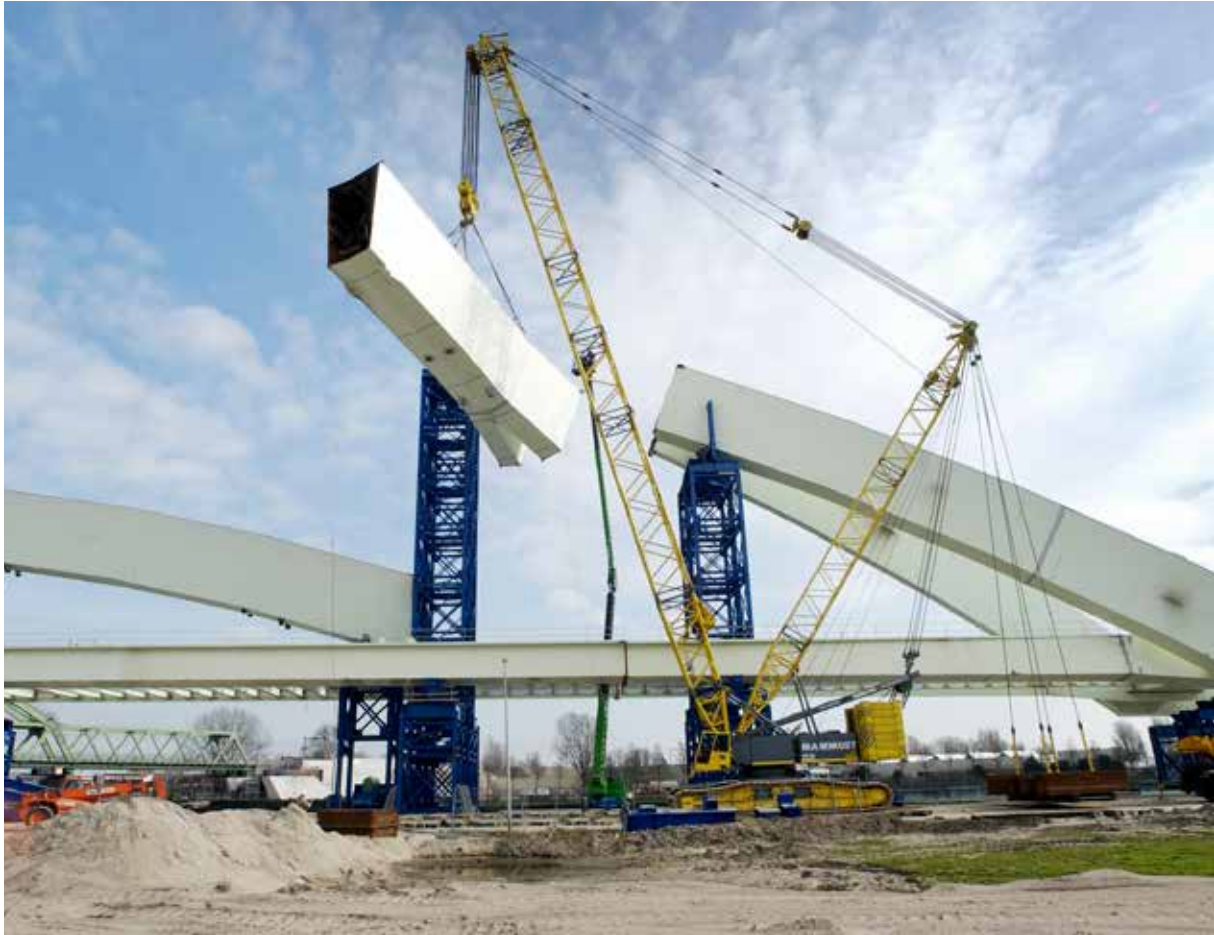
Montage Werkspoorbrug, Utrecht
