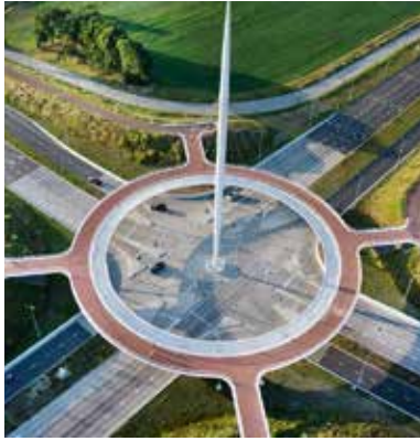
Brug Hovenring - Eindhoven
